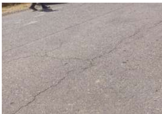
Longitudinal Cracking
